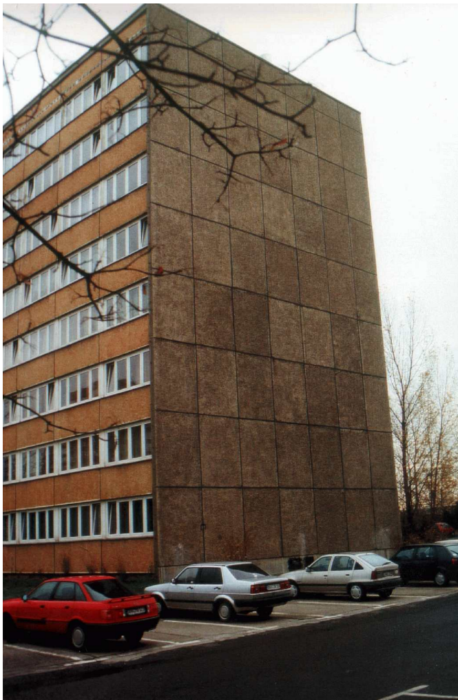
Bild 3: Fassadenansicht vor der Sanierung
